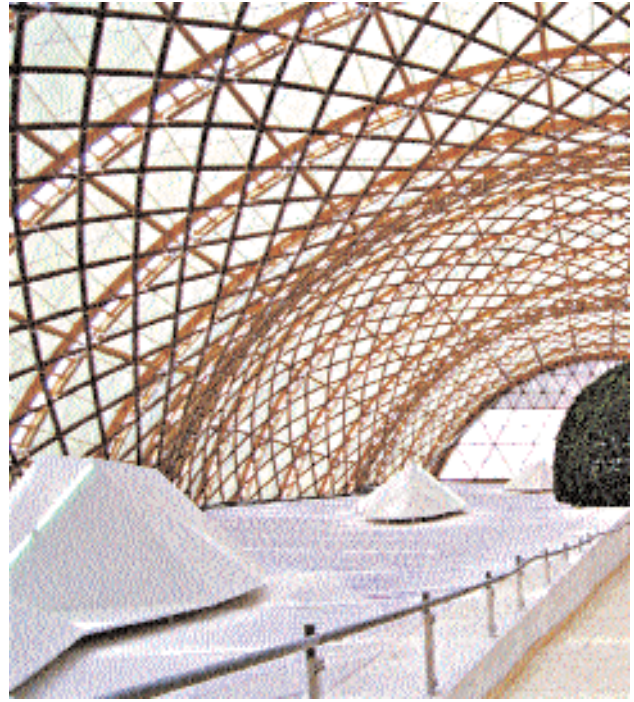
Внутреннее пространство и элементы конструкции
