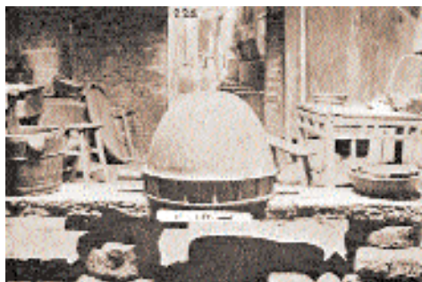
Перегонный аппарат и охлаждающий котел на винокуренном заводе в городе Дунчэн провинции Аньхуй. Из книги: Hommel R. China at Work. New York, 1937.
